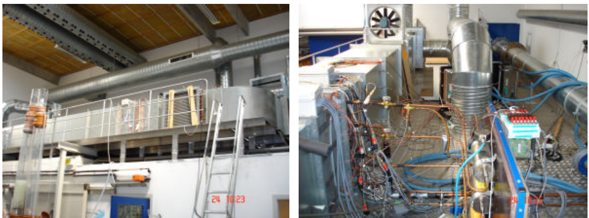
Figur 16: Udførelse af luftkanal oven på klimakammer på Teknologisk Institut.
