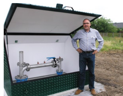
Enopsol-stifter Stig Niemi Sørensen ved returbrønden i et af de ATES-anlæg, der allerede er etableret i Danmark. Foto: Enopsol.
