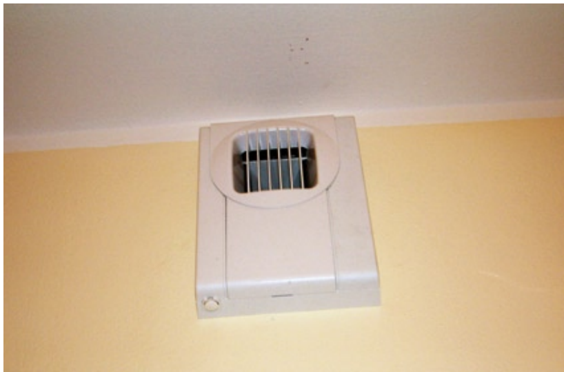
Passiv, fugtstyret udsugningsventil. Et indbygget fugtfølsomt bånd regulerer spjældets åbningsgrad.
