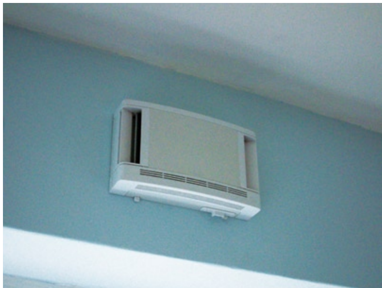
Passiv, fugtstyret udeluftventil. Et indbygget fugtfølsomt bånd regulerer spjældets åbningsgrad.
