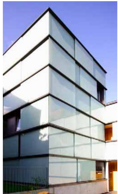
Let og højsoleret træfacade med glas som regnskærm Sebastianstrasse, Dornbirn Baumschlagel & Eberle, 2002
