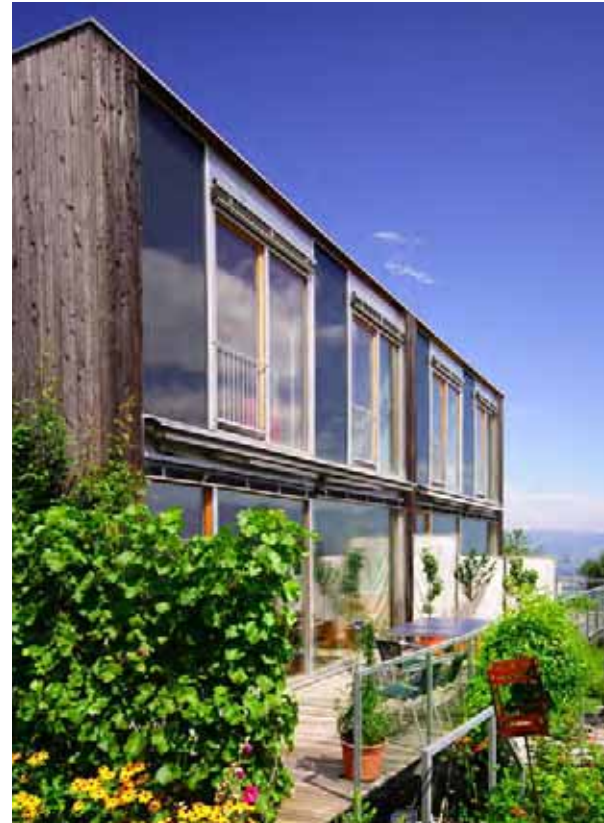
Lavenergirækkehuse, Batschuns Walter Unterrainer, 1998
