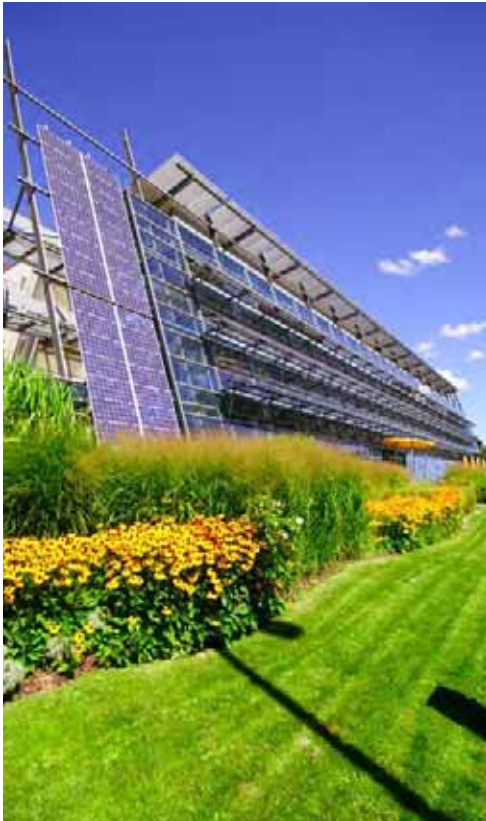
Facadeintegreret elproduktion med solceller Solar-Fabrik, Freiburg Rolf & Hotz, 1998
