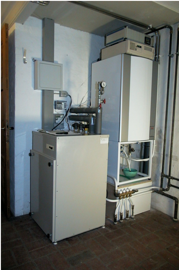
Varmepumpeinstallation
