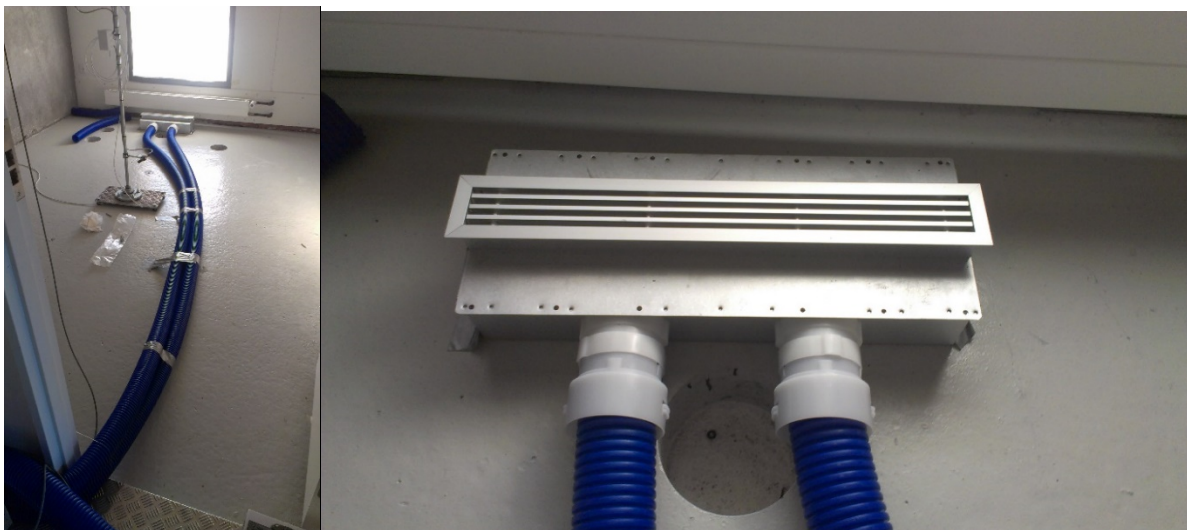
Figur 8-4: Kanalføring og indblæsningsarmatur.
