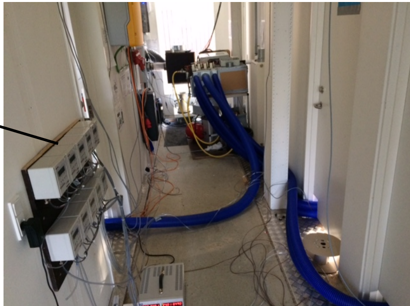
Figur 8-3: Fotografi af opstilling fra enden af gangen.
