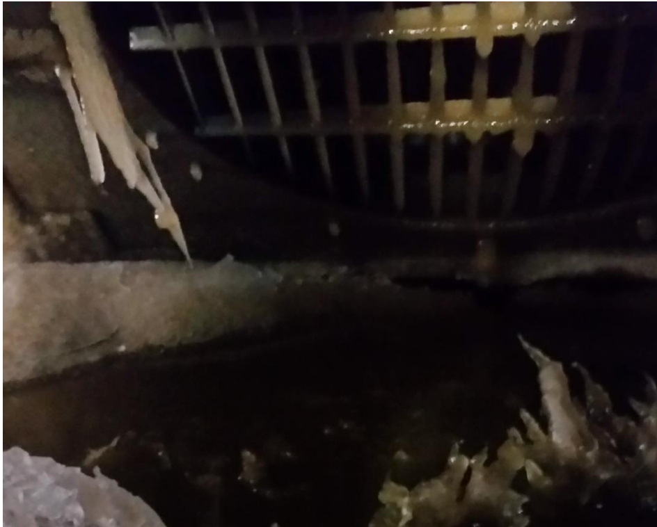
Figur 51 Der sker en påfrysning på knockoutpladerne, men ikke så meget, at det påvirker funktionen.
