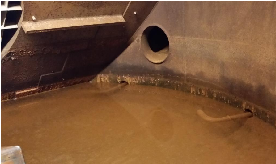
Figur 37 To af de seks dyser, som kunne justeres i alle retninger. Udløbshastigheden af vandet ud af dyserne er ca. 14 m/s.
