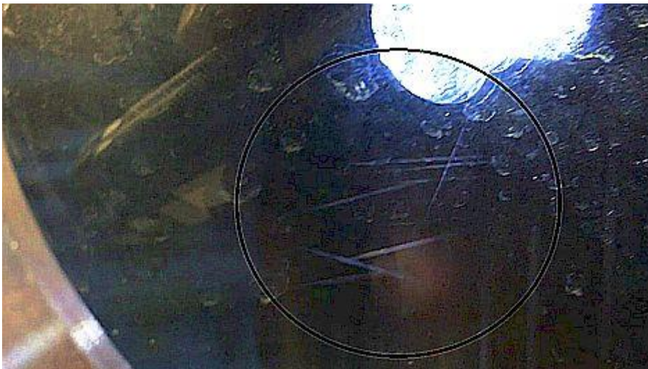
Figur 35 Dråber eller iskrystaller i indsugningen til kompressoren efter dråbefanget i fordamperen. Taget fra video.
