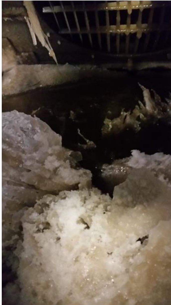
Figur 39 Isen fryser til en fast overflade pga. manglende omrøring fra dyserne.
