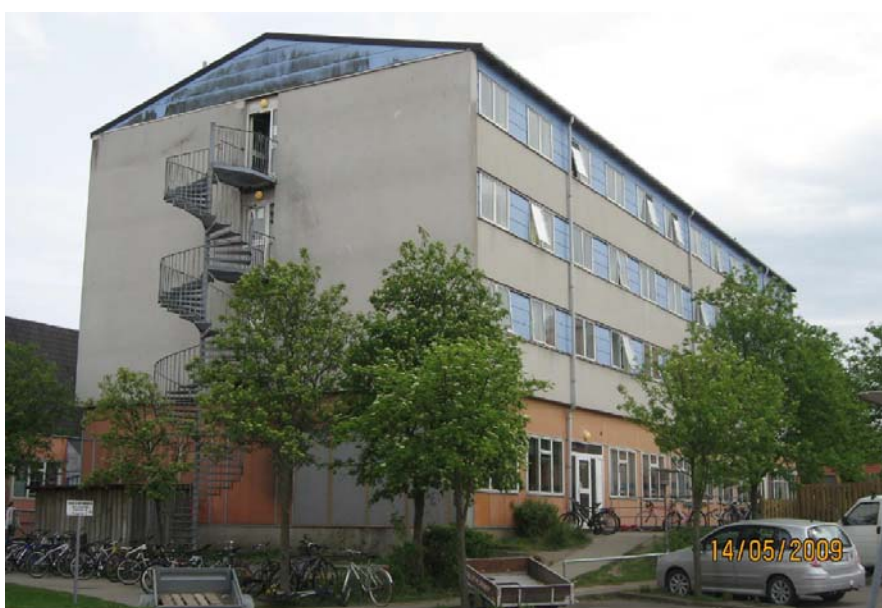
Figur 3.8: Blok A 14 år efter facaderenoveringen og vinduesudskiftningen i 1995.
