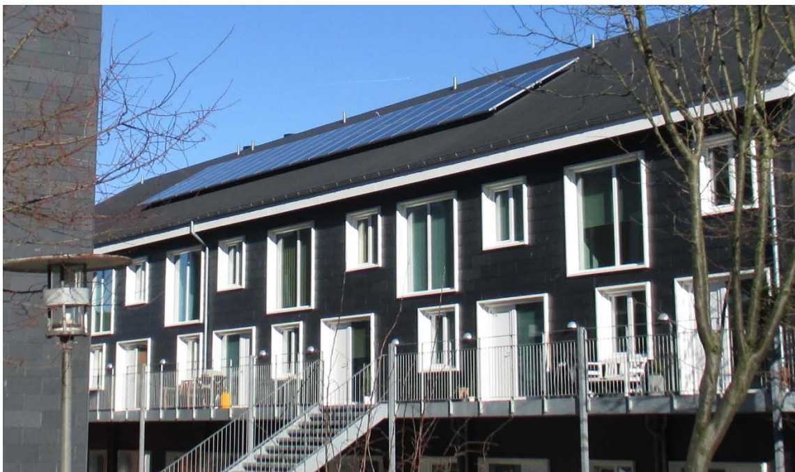
Figur 4.6: Solcelleanlægget på taget af Blok B.
