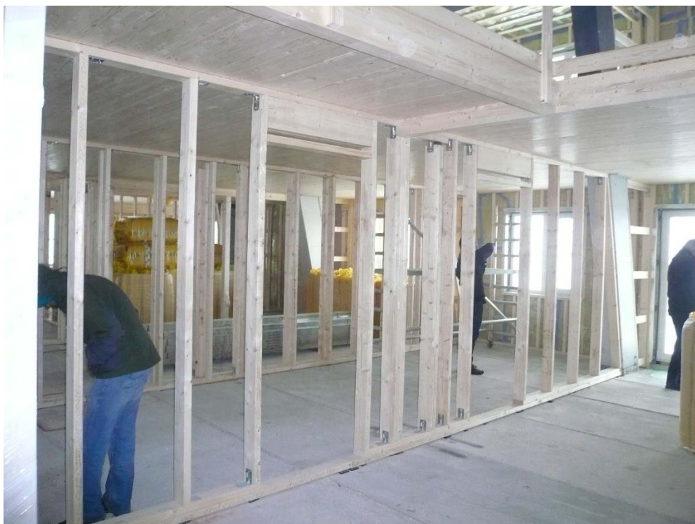
Figur 3.7: Opførelse af etagedæk og vægge på 1.-2. sal i Blok B.
