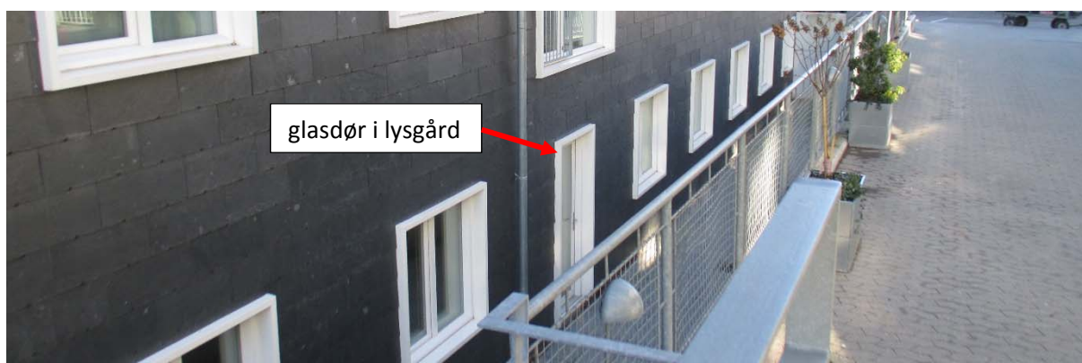
Figur 3.18: Vinduer og dør i lysgård.
