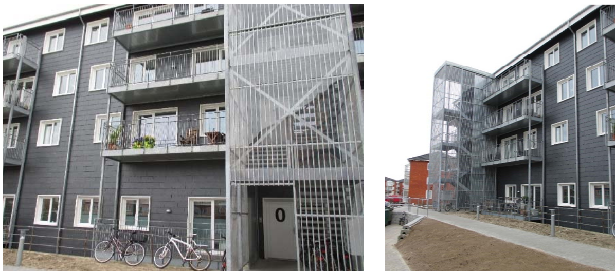
Figur 3.16: Blok A's vestlige facade med trappetårne.
