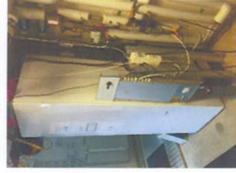
Nilan brugsvandsvarmepumpe med 200 liter varmtvandsbeholder
