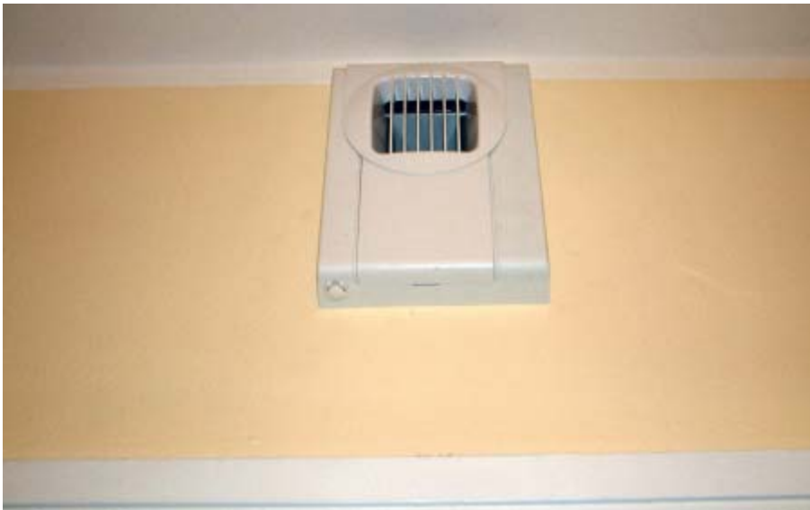
Figur 4. Fugtstyret udsugningsventil i wc- og baderum; fabrikat Exhausto type BXL 879. Ventilens udvendige mål er ca. 16 x 23 cm.
