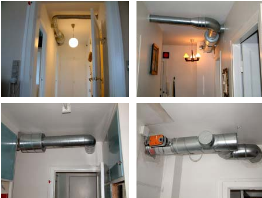
Figur 31. Eksempler på kanalføring i forsøgslejlighederne.
