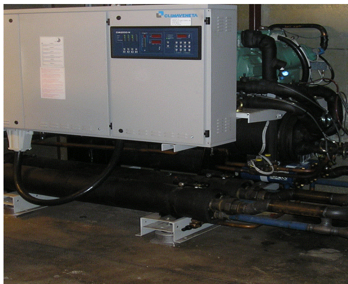
Jordvarmepumpe til opvarmning af svømmehal (Vellinge)
