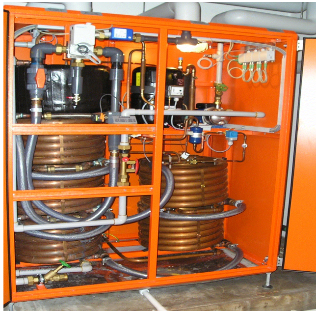
Unit for genvinding af varme fra bruservand (Vellinge)
