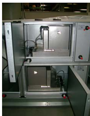
Figur 32: NOVENCO Climaster ZCN 9/6 unit og sektionerne med Munters RA6 befugtere.
