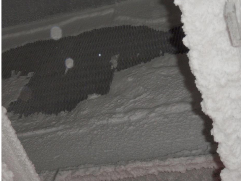
Billede 7: Køleflade, som næsten er tildækket af rim.
