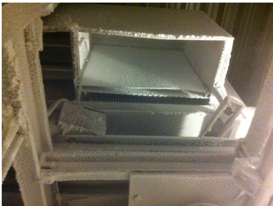
Billede 18: Gitteret inden det skrubes/bankes rent.
