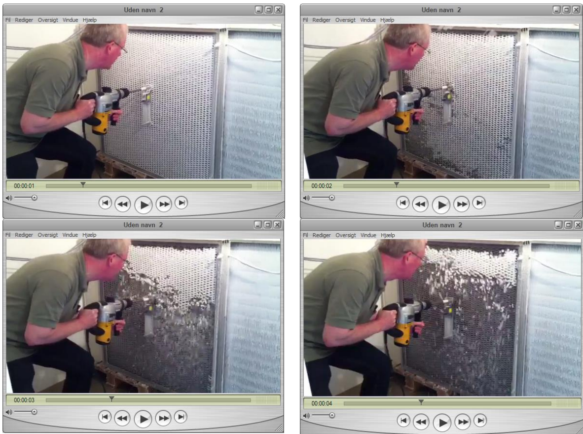
Billede 16: Rensning af gitter - sekvenser med cirka et sekunds mellemrum.
