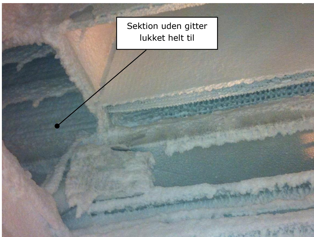
Billede 19: Tilrimet fordampere. Sektionen uden gitter er helt tillukket.
