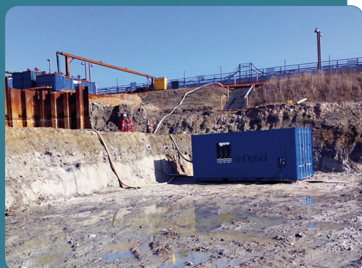
Enopsol har under projektet udviklet en mobil testfacilitet til de indledende forundersøgelser af grundvandsegenskaberne. Foto: Enopsol.
