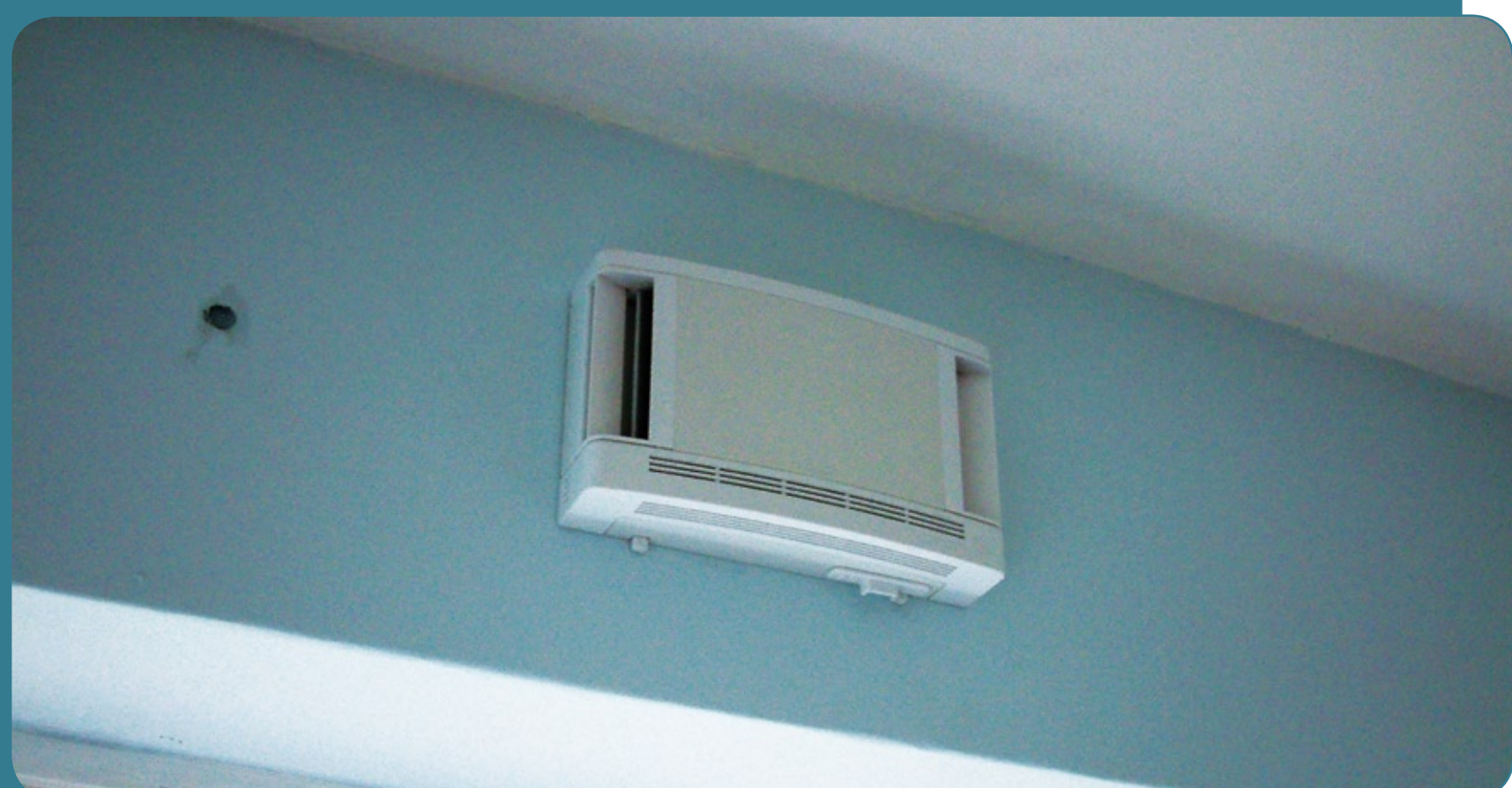
Passiv, fugtstyret udeluftventil. Et indbygget fugtfølsomt bånd regulerer spjældets åbningsgrad.
