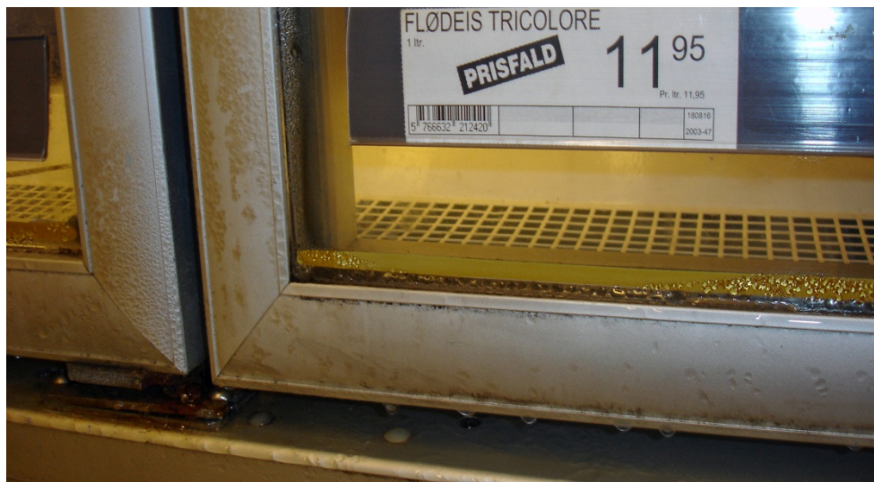
Figur 2: Kondens på fryseskabets ramme.
