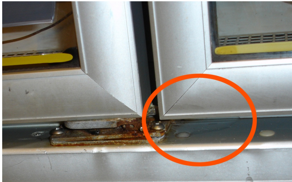
Figur 21: Dannelsen af kondens starter i midten af skabet under de to låger.
