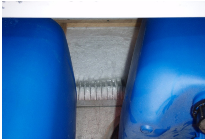
Figur 36: Tilblokning af fordamper.
