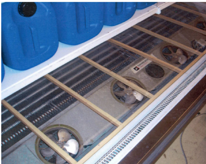
Figur 4: Fordamper i kølemøbel.
