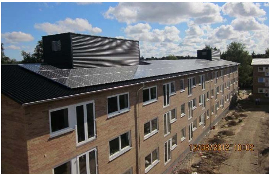
Figur 5. PV-system og ventilationssystem på taget af boligblok.
