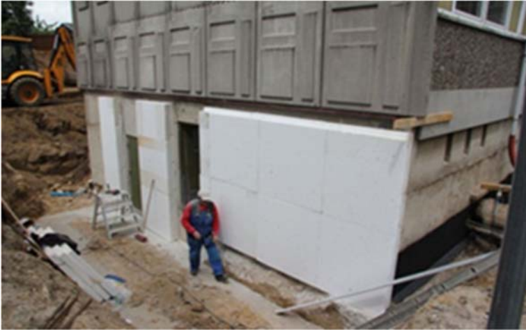
Figur 2. Efterisolering af kælderydervæg.
