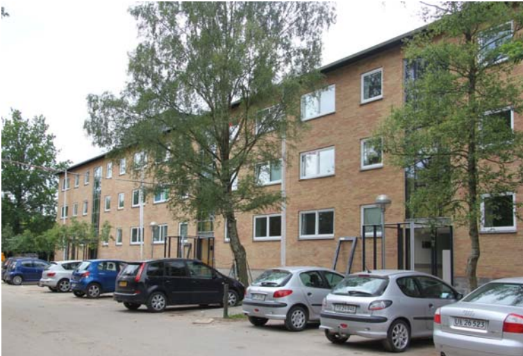
Figur 4. Den nye murede facade på én af boligblokkene efter reoveringen.
