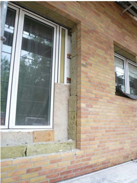
Figur 3. Ny isolering af klimaskærmen samt nye vinduer.
