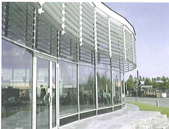
Facadeelementer af anodiseret aluminium. Foto: Sapa Profiler A/S.
