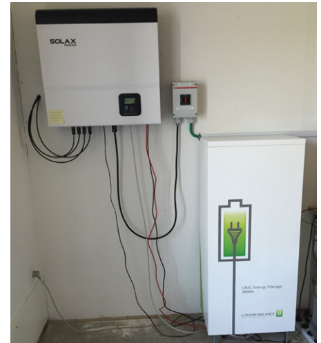
Figur 3. Forsøgsopstilling nr. 2 med Solax inverter med batterisystem fra Lithium Balance.
