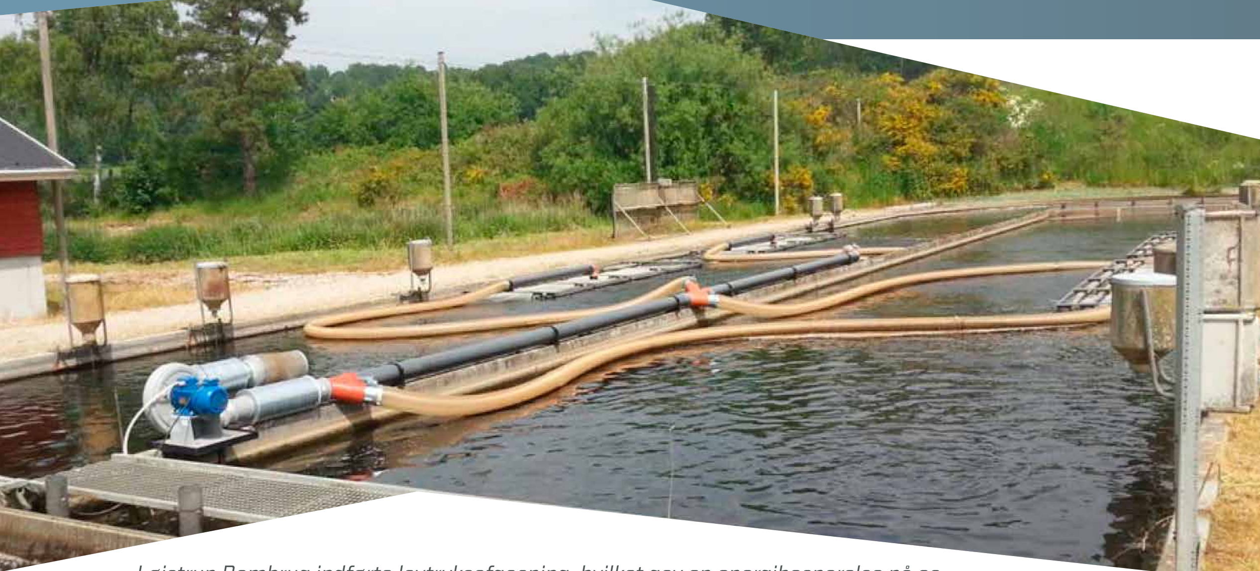
Løjstrup Dambrug indførte lavtryksafgasning, hvilket gav en energibesparelse på ca. 300.000 kr. årligt. Samtidig kunne man fodre flere fisk, og dermed producere mere. Det værdisattes til ca. 1,2 mio. kr. årligt.
