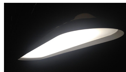
Opsætning af de nye LED-armaturer på gange og patientstuer, hvor armaturet passer præcist i hullerne fra de tidligere loftsarmaturer.
