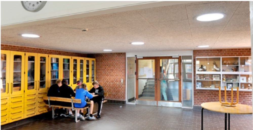
I et gangareal hvor eleverne opholder sig i frikvarteret på Hotherskolen er implementeret hybrid lysskakt med LED belysning.
