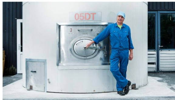
Klaus Skouenborg, maskinmester hos Jensen's Køkken, ved den vandtank, der i løbet af dagen akkumulerer varme fra produktionen til varmt vand, der bruges til den omfattende rengøring på fabrikken.
