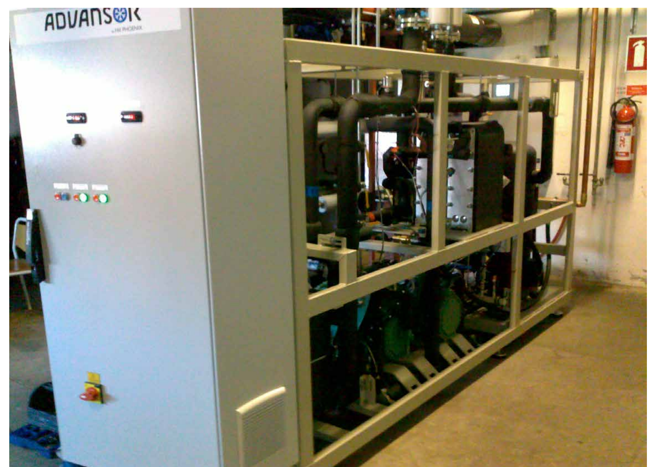
Med et CO 2 varmepumpeanlæg kan overskudsvarme fra et ammoniak køleanlæg opgraderes til en temperatur, der kan udnyttes i den hygiejniske krævede rengøring hos Jensens Køkken.
