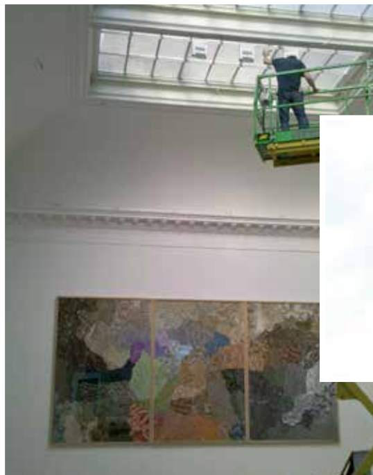
Installation af HighLight på kunsthall Charlottenborg. Liften er ikke nødvendig igen, når installationen først er lavet.
