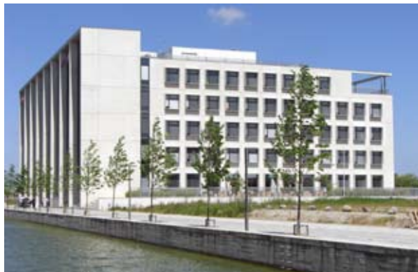
Københavns Energis hovedkontor er projekteret med tunge konstruktioner for størst mulig energilagring og er udstyret med naturlig ventilation suppleret med frikøling.
