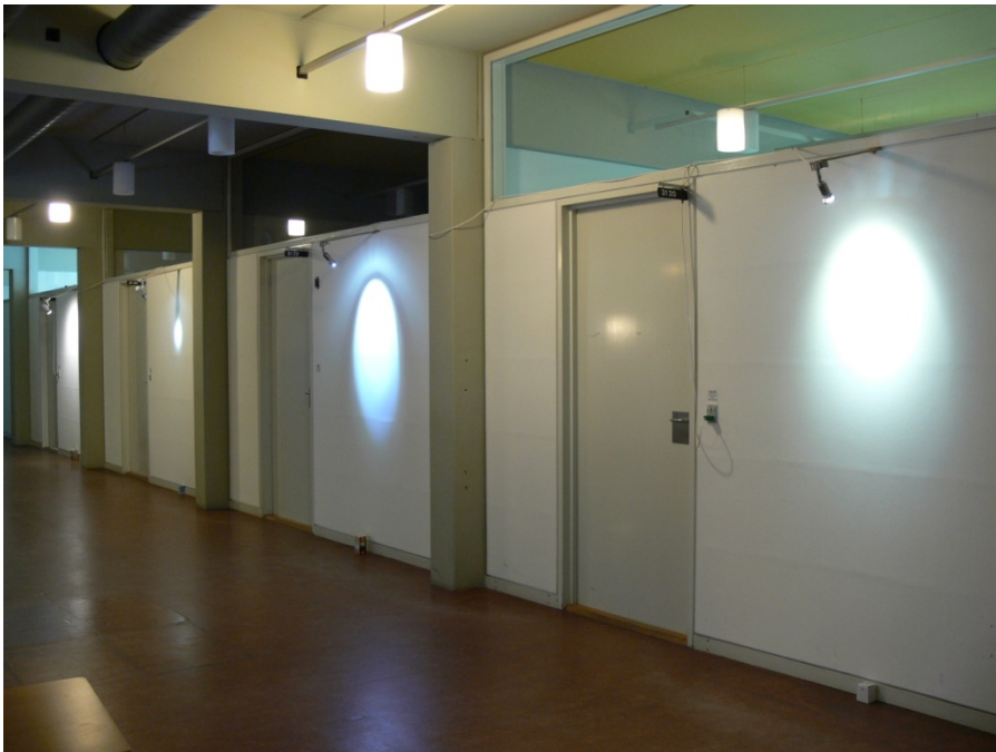
Figur 5.8 Spot- og erstatningslyskilder blev monteret ved overkant væg i en hældning på 45°. Foto: Steen Traberg-Borup
