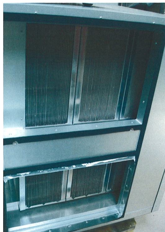
Udsugningsfilter F5
