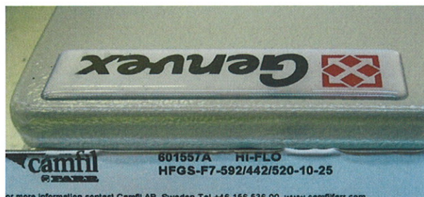
indblæsningsfilter F7
