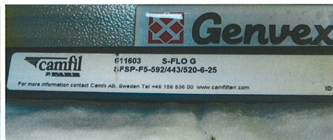
Udsugningsfilter F5
