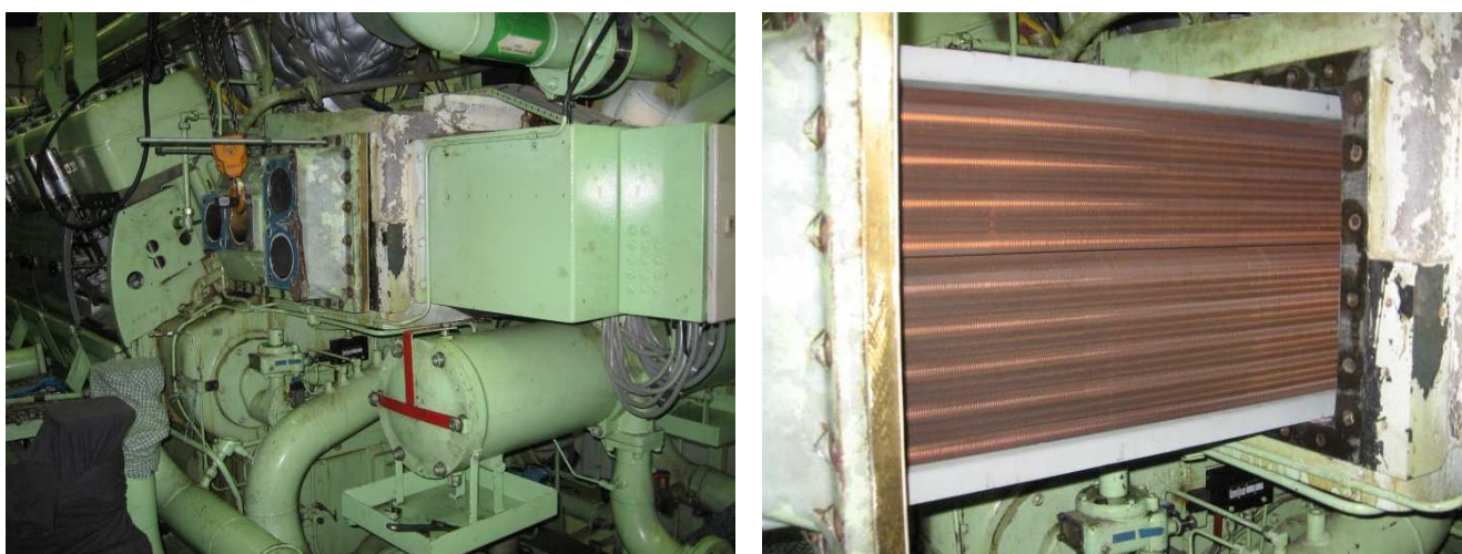
Figur 4-12 Ladeluftskøler monteret hos gartneriet Varpelev Tomater A/S
