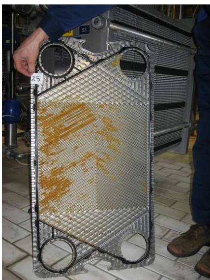
Figur 4-4 Veksler med sol-gel belagte plader. Kalk og andet snavs var meget let at fjerne.
