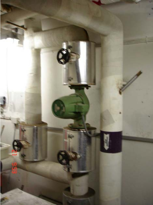
Figur 3.4. Cirkulationspumpe i blok 5
