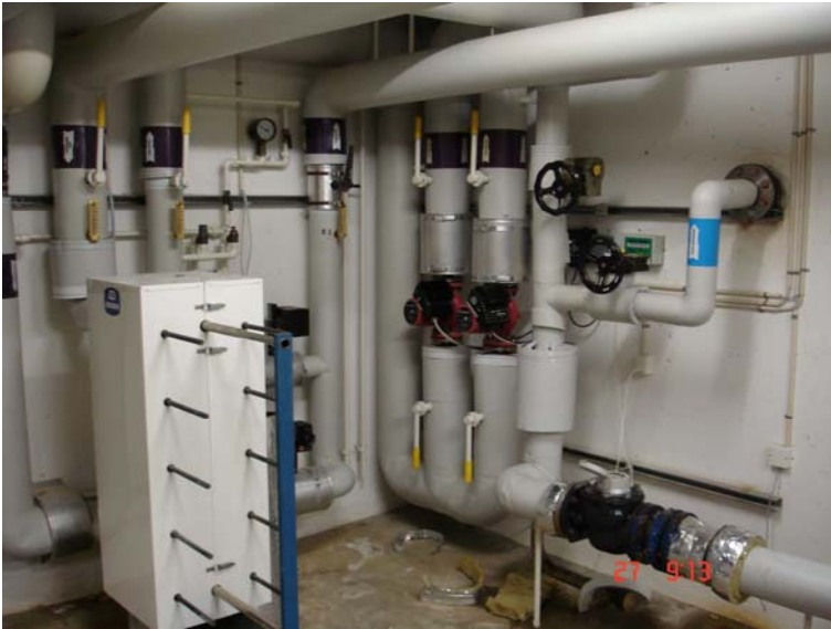
Figur 3.7. Cirkulationspumper i Utterslevhuse
