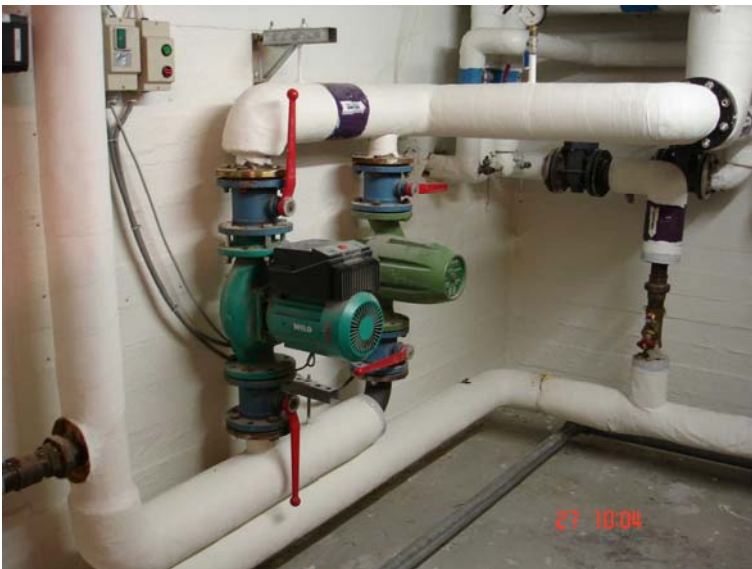
Figur 3.10. Cirkulationspumpe i Kildevænget
