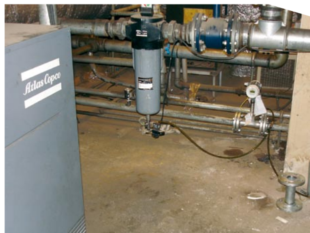
Der blev målt optagen effekt, flow, temperatur og afgangstryk over længere perioder. Her måles på den lille kompressor
