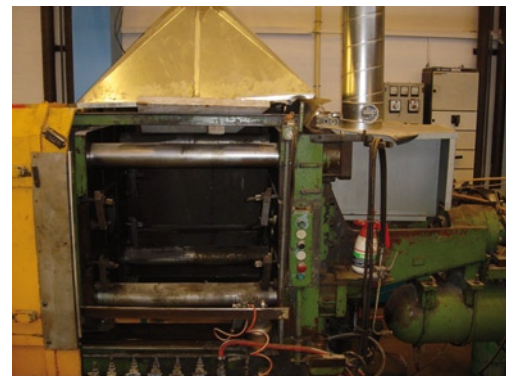
Beregnet udsug til varmeovn.
