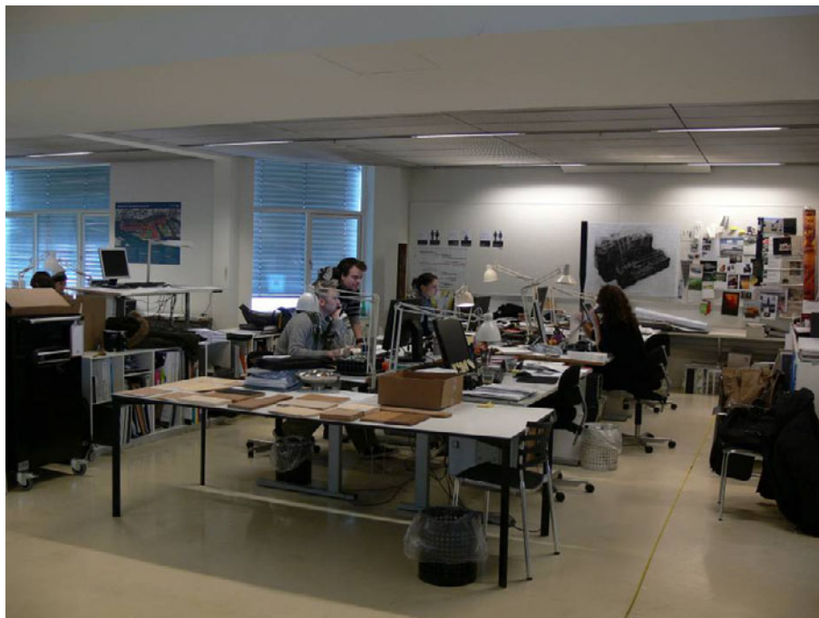
Figur 39. Foto af forsøgsområdet, der viser det eksisterende belysningsanlæg med armaturer indbygget i loftet.
