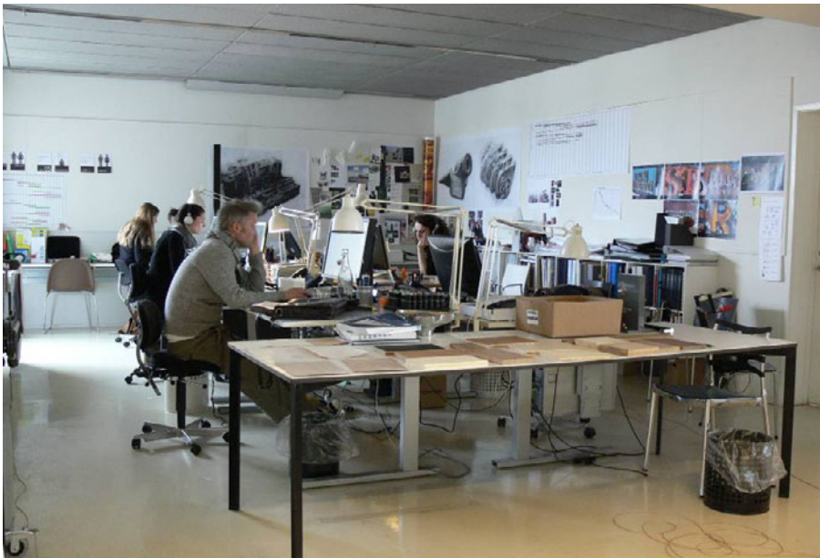
Figur 35. Forsøgsområde hos Henning Larsen Architects med begrænset dagslys fra vinduet i det nordøstlige hjørne af forsøgsområdet. Eksisterende armaturer med 1x28 W T5-rør er indbygget i loftet.
