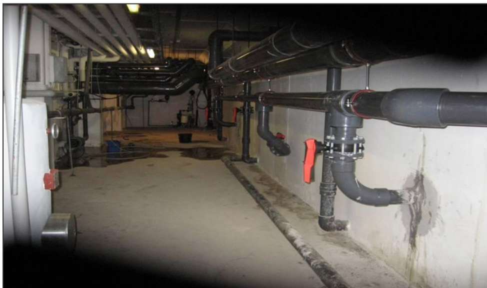
Figur 2 Der måtte indbygges ekstra rør til vandfordeling i 50 m bassin
