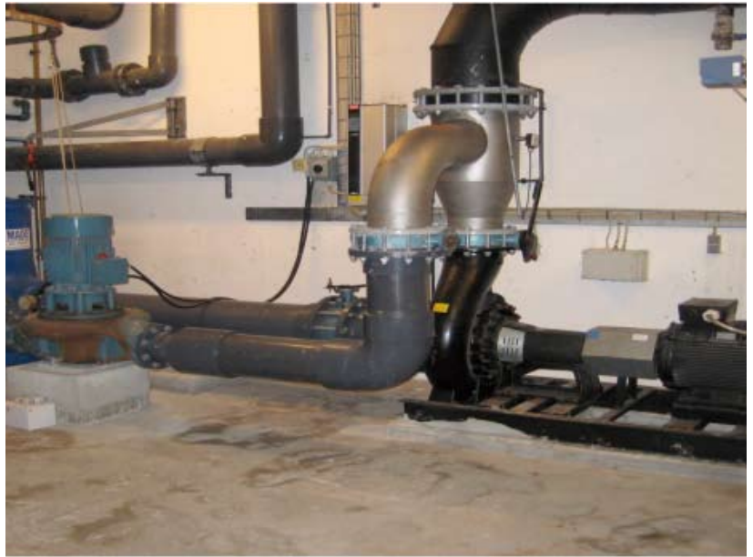
Ny pumpeinstallation med blokpumpe for 50 m bassin. Det nye filter med lavt tryktab ses tv. Den ene af de gamle pumper kan fungere som reservepumpe.
