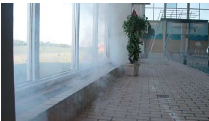
Røgstest til undersøgelse af luftfordelingen før renovering af ventilation i Korsør Svømmehal
