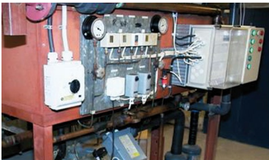
Varmepumpe i svømmehal til opvarmning af brugsvand
