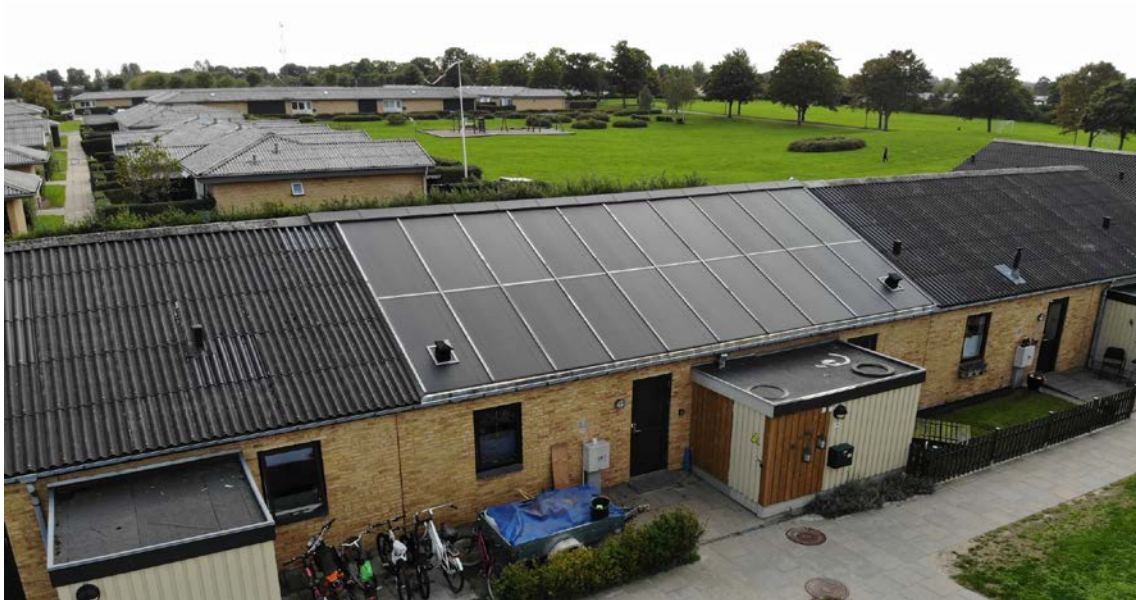
Figur 1. Nordsiden af Lokes Plads 38 med solcellemoduler på taget. PVT-E moduler er placeret på tagets sydside. Varmepumpe, batteri og anlæggets tekniske installationer er placeret i skuret.
