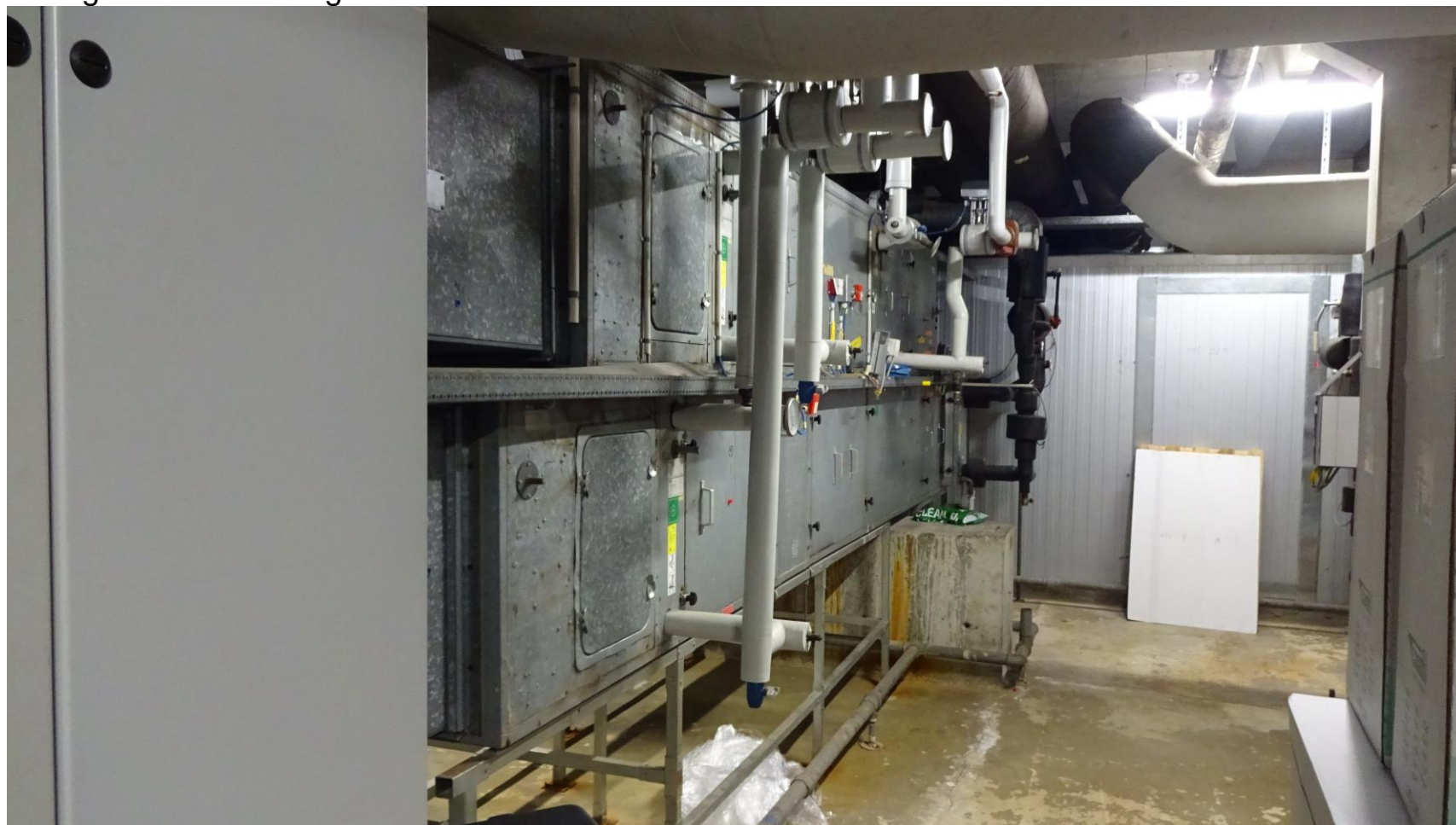
Indblæsningsanlæg efter hovedanlæg
