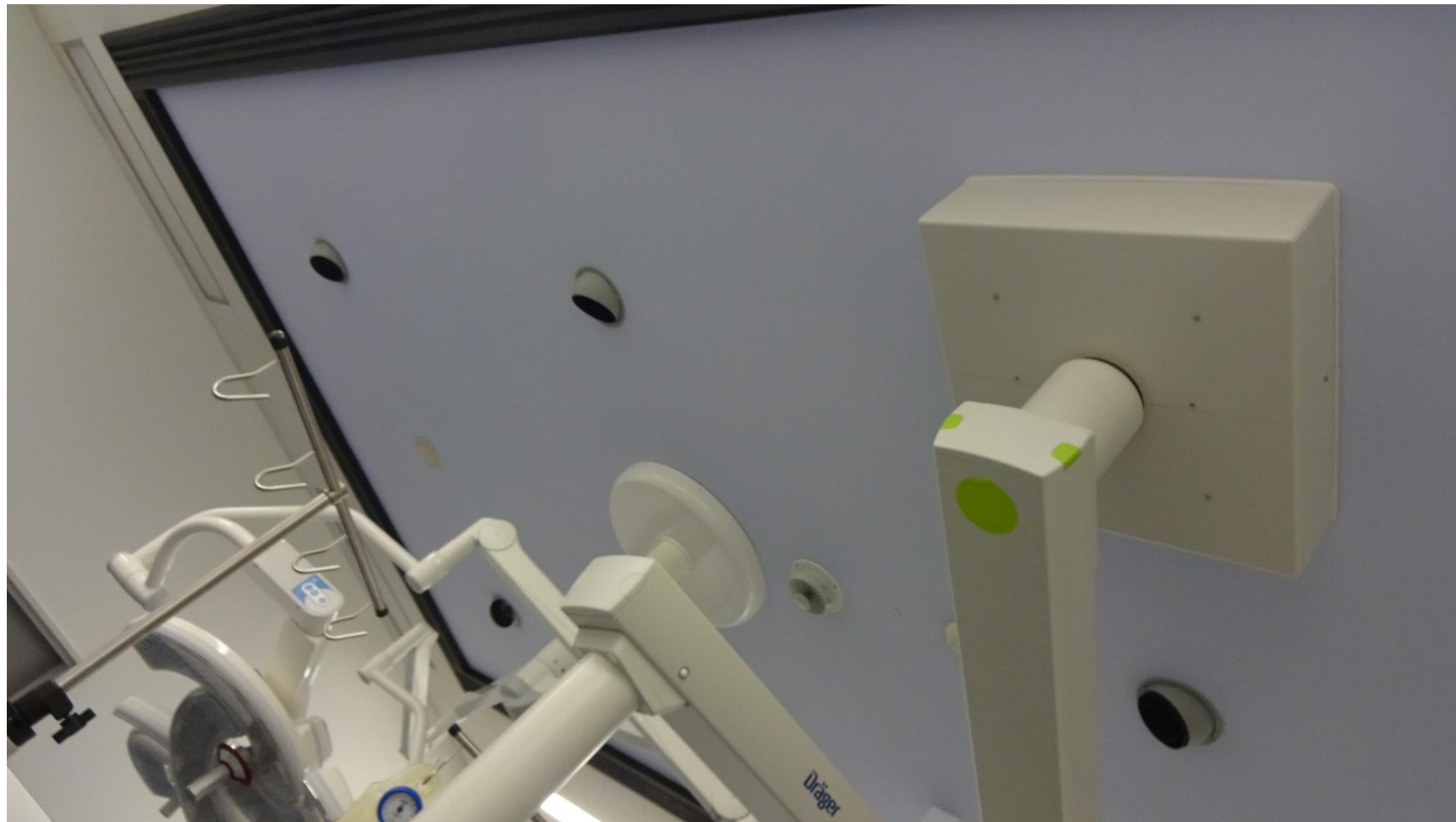
Indblæsningsspalter i loft over OP-lejet
