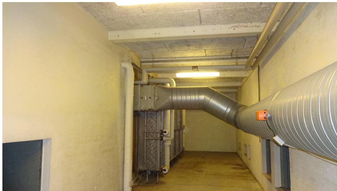
Bypassmulighed for VE 251 og VE252 for fælles sugekammer.
