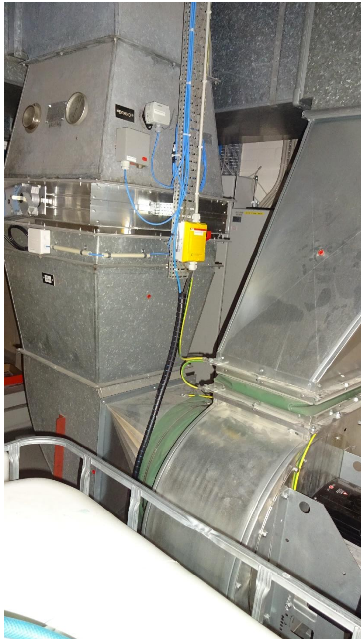
Udsugningsventilator
