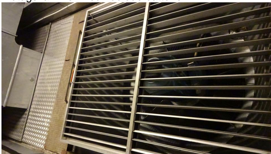
Indblæsningsventilator ACN 1400 2 stk.
