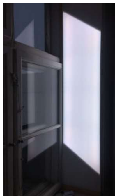
Fig. 5 Patientstuer på Psykiatrisk Center København med (a) dagslys fra vinduet, (b) døgnrytmebelysning i loftet og i væggen. (c) Det særligt udviklede LED lyspanel som ligner sollysindfald/en solstråle.
