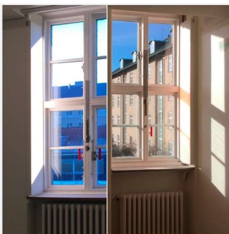
Fig 1. Billedet til venstre viser hvordan LED panelet bygget ind i vindueslysningen efterligner sollys refleksion. Billedet til højre viser naturligt sollys refleksion på væggen.
