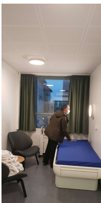
Fig. 5 Patientstuer på Psykiatrisk Center København med (a) dagslys fra vinduet, (b) døgnrytmebelysning i loftet og i væggen. (c) Det særligt udviklede LED lyspanel som ligner sollysindfald/en solstråle.
