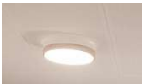
Fig. 4. Særligt udviklet loftarmatur med intelligent LED baseret døgnrytmebelysning
