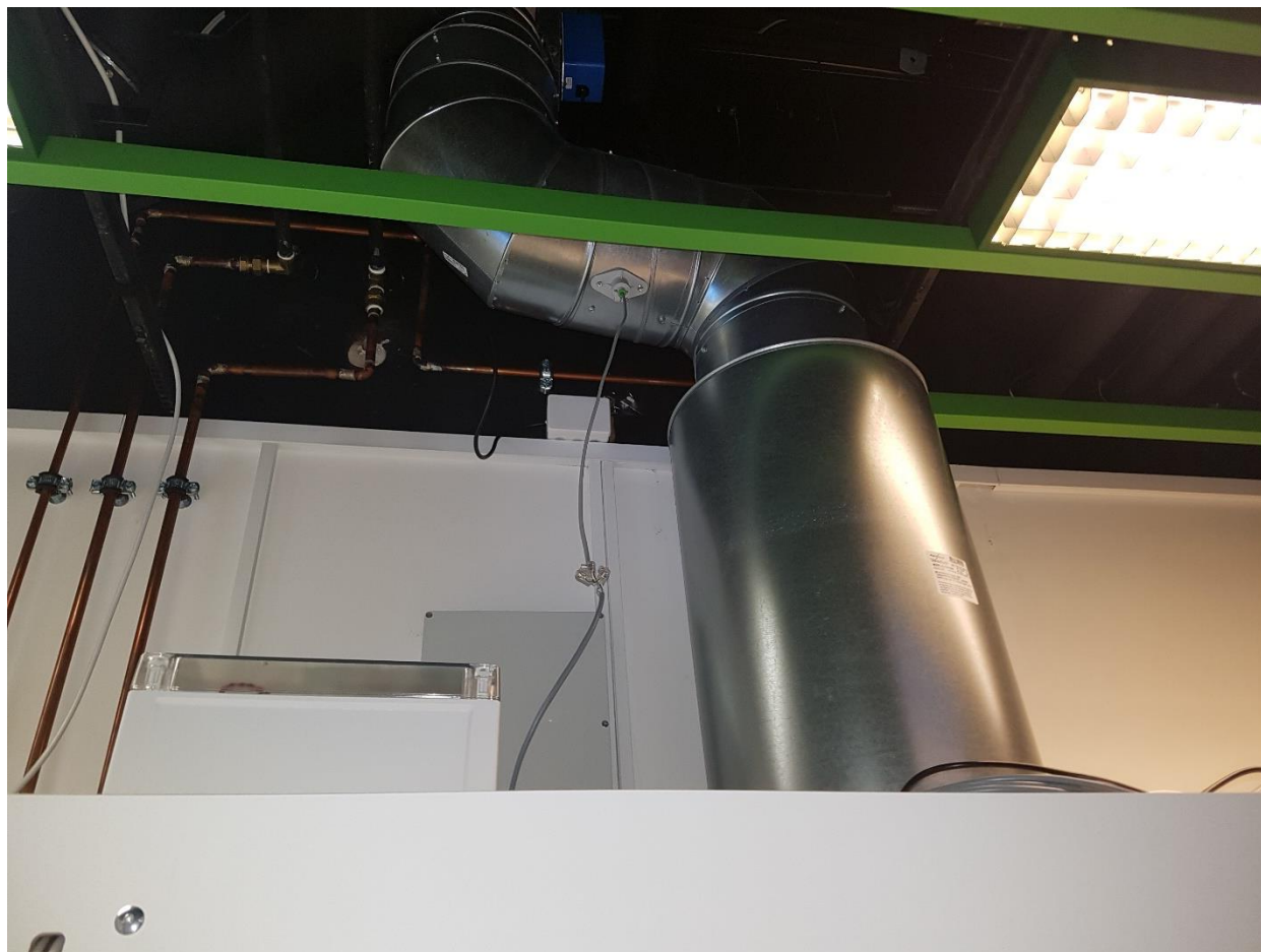
Figur 9.1 Placering af trykflow til efterfølgende beregning af luftflow i kanal.
