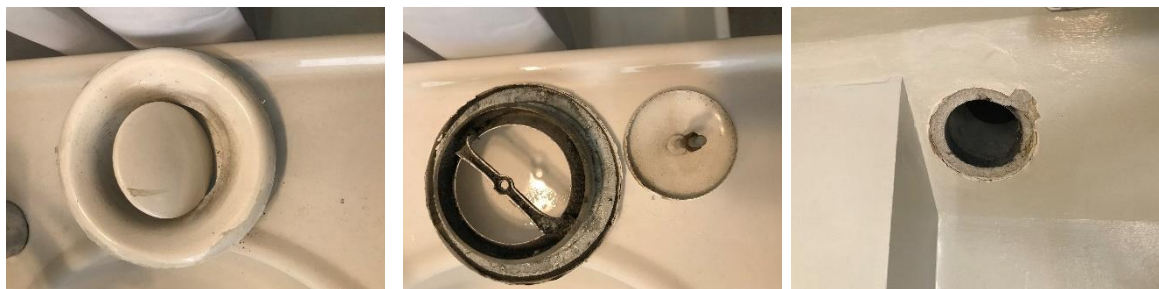
Figur 22: Udsugningsventil i badeværelse
