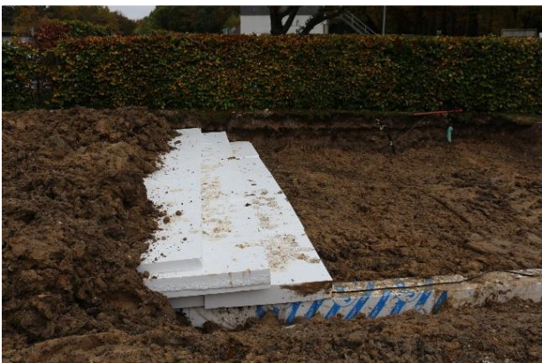
Billeder fra installationen af jordvarmelageret
