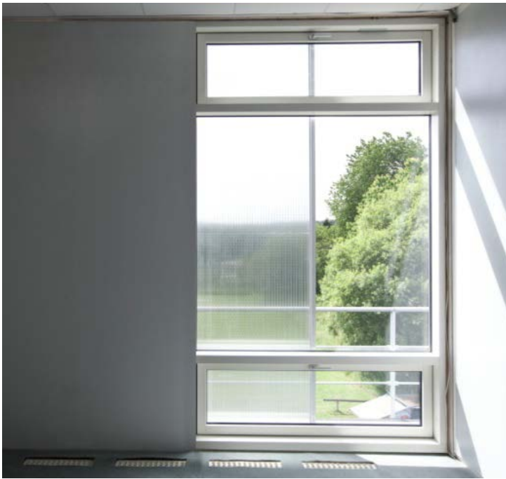
Figur 34. Energy Frames element, der både varmesolierer og tillader dagslyset at passere. Foto: Forfatterne.
