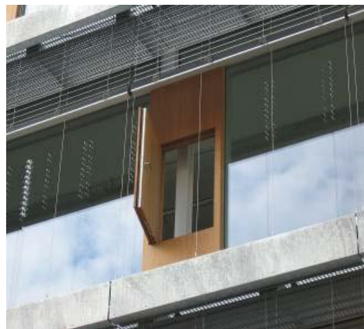
Figur 37. Alternativ løsning til det almindelige oplukkelige vindue, her en ventilationslem, som måske giver en stærkere oplevelse af åbning mod det fri.
