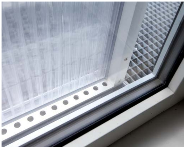
Figur 40. Energy Frames ventilationselementet med forskydelige hulprofiler indbygget foroven og forneden, således at åbningerne kan reguleres. Foto: Forfatterne.
