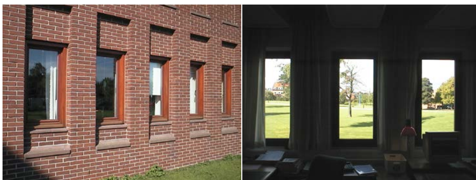
Figur 2. Udsyn og udsigt fra kontorrum, med en markant opdeling af vinduesarealet i forholdsvis smalle vinduer med faste partier imellem. Da udsynet til omgivelserne prioriteres meget højt af brugerne, bør vinduesudformningen vælges med hensyntagen til den faktiske udsigt og rummets brug, især brugernes placering i rummet. Personer, der sidder et stykke fra vinduerne, vil opleve, at den valgte vinduesudformning ødelægger udsigten, samtidig med at der til tider kan opleves ubehagsblænding pga. kontrasten mellem vinduerne og de faste partier. Foto: Erwin Petersen.
