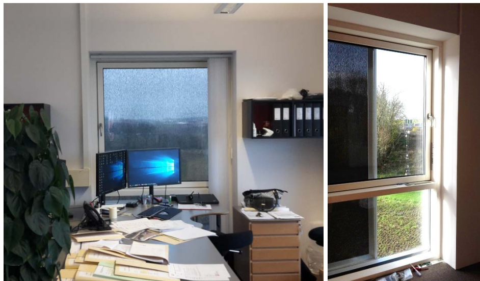
Figur 24. Foto fra lokalet med dynamiske skodder med en grå screendug. Til højre set indefra et af lab-kontorerne i stueetagen med Energy Frames elementet kørt halvt for vinduet.
