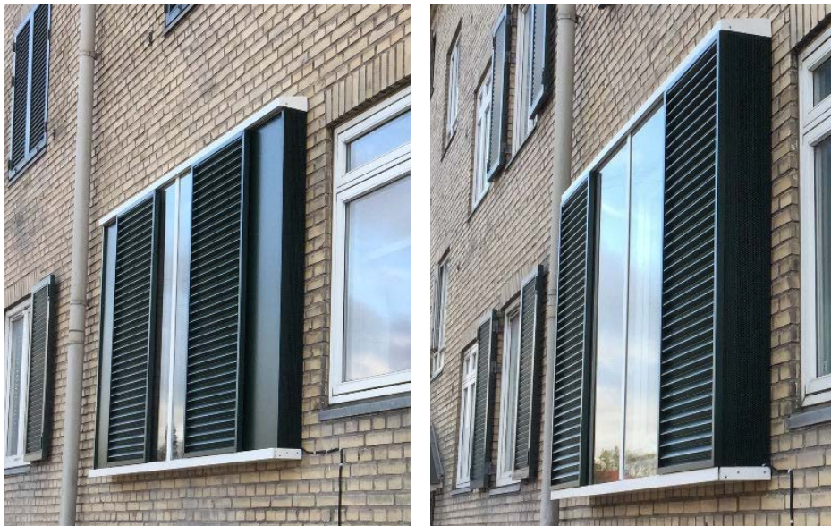
Figur 47. Foto af prototyperne på de to typer nyudviklede lydskodder, dels med samlet spalteåbningsareal på 0,14 m 2 (til venstre), dels 0,35 m 2 monteret (til højre). Foto: Art Andersen.
