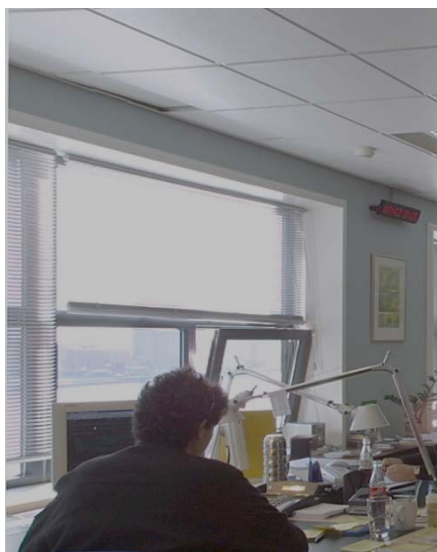
Figur 11. Eksempel på konflikt mellem afskærmning og udluftning. Persiennen kan kun trækkes halvt ned, når vinduet er åbent.
