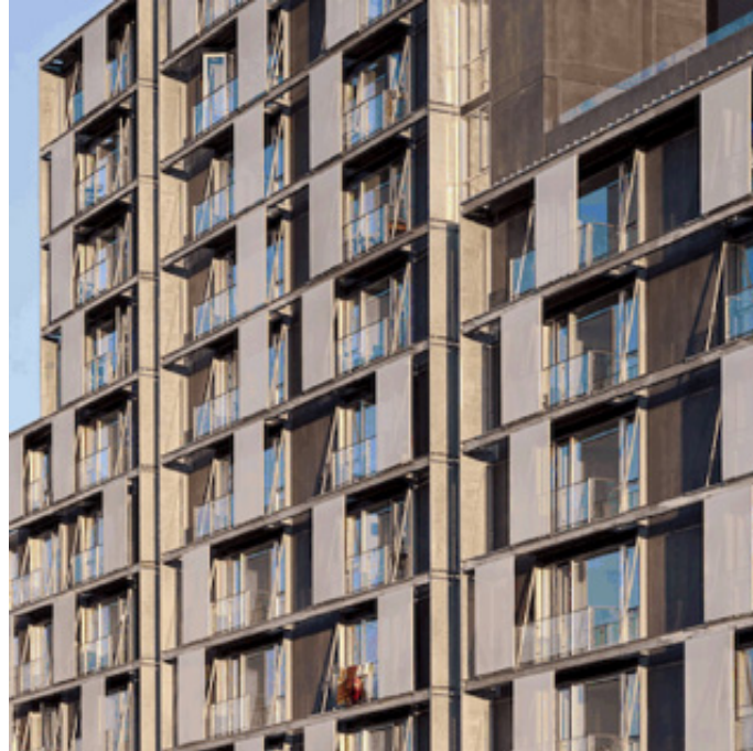
Figur 18. Manuelt bevægelige tekstilrammer som solafskærmning på altanen i almennyttige etageboliger Sejlhuset. Foto: Art Andersen.
