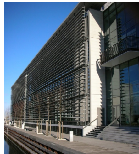
Figur 15. Bygning med faste vandrette lameller, som reducerer både dagslyset og det positive solvarmetilskud om vinteren.
