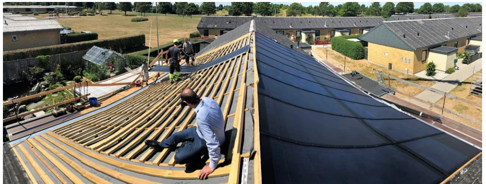
Figur 5-3 Pilotanlægget. Til højre er almindelige PV og til venstre PVT-E moduler under montage.
