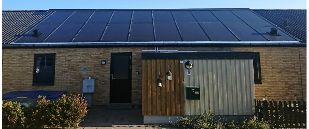
Figur 5-2 Pilotanlægget set fra nordsiden. Her er der 50 m 2 PV. Varmepumpe mv. er anbragt i det udvidede udhus.
