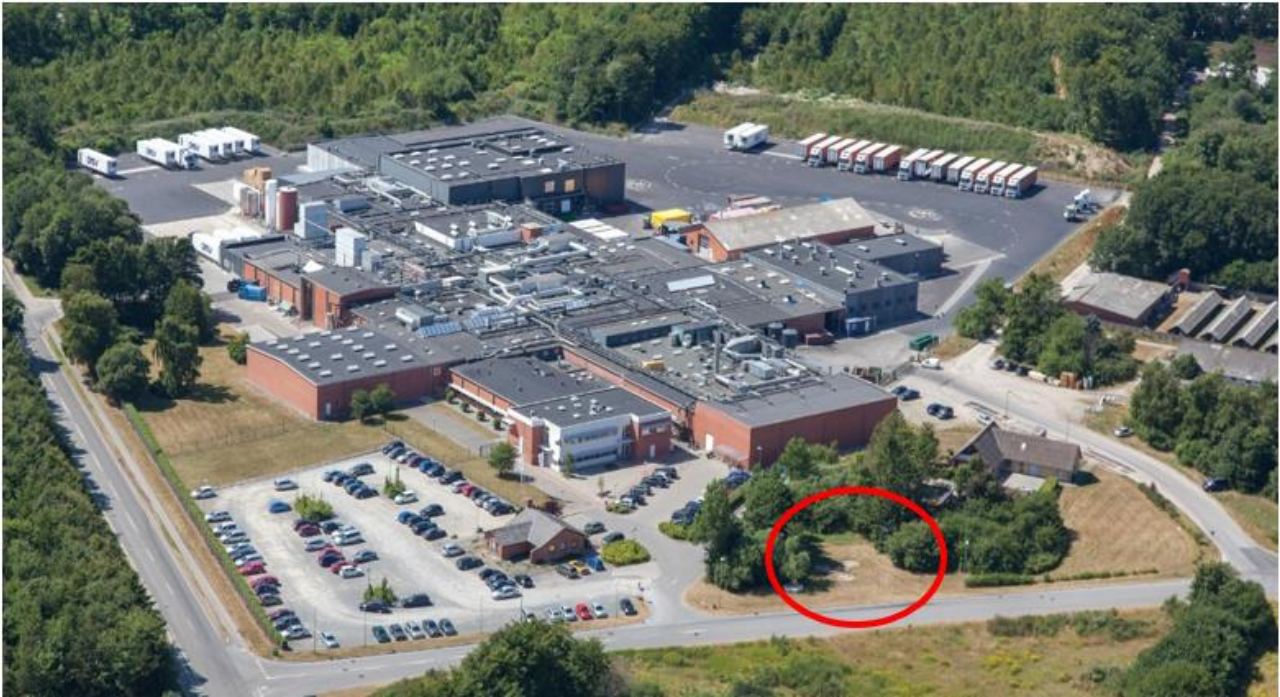
Figur 7 viser luftfoto over Danpo produktionsfabrik
