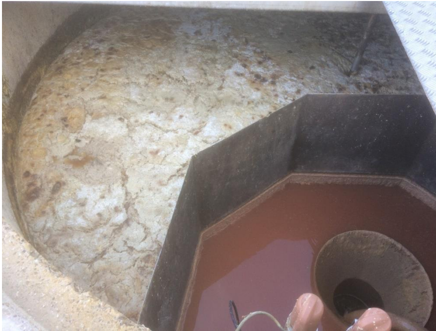
Figur 7 - Foto af simpelt fedt- og sandfang
