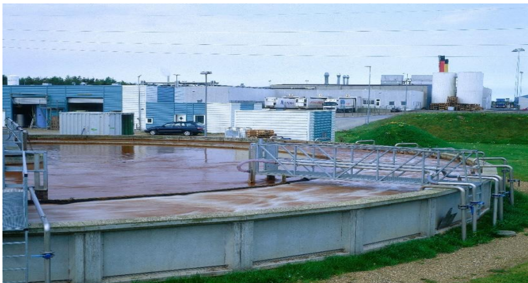
Figur 11 - Foto af aktivt slam anlæg
