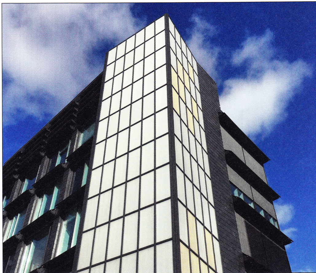
Figur 2. Solvæg på Kalkværksvej 10A, Aarhus Kommune.
