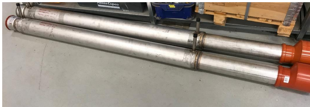
Figur 9. Faldstamme-varmeveksler installeret i Rydevænget – det indvendige rør fungerer som faldstamme med en længde på 3 m, dvs. med en overlængde der kan afkortes, så det passer til forholdene på stedet.
