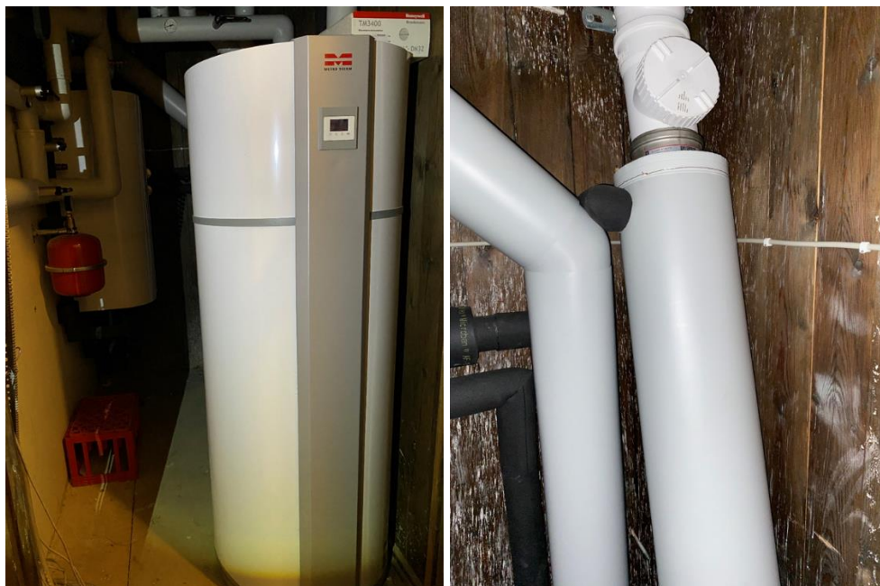
Figur 10. METRO THERM's Microbooster varmepumpe på billedet til venstre og varmeveksler installeret på faldstammer på billedet til højre. Et rensestykke er installeret over varmeveksler for at tillade rensning/skylning af faldstammen.
