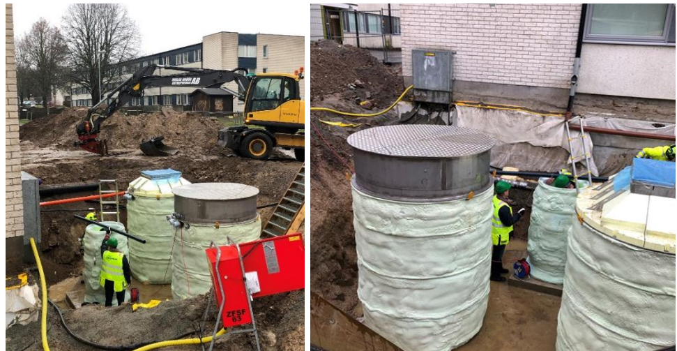
Figur 25. Etablering af anlægget i Alabastern
