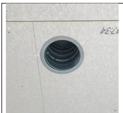
Figur 9. Afslutning på ventilationsmontage i loft. Airy armatur kan nu monteres.
