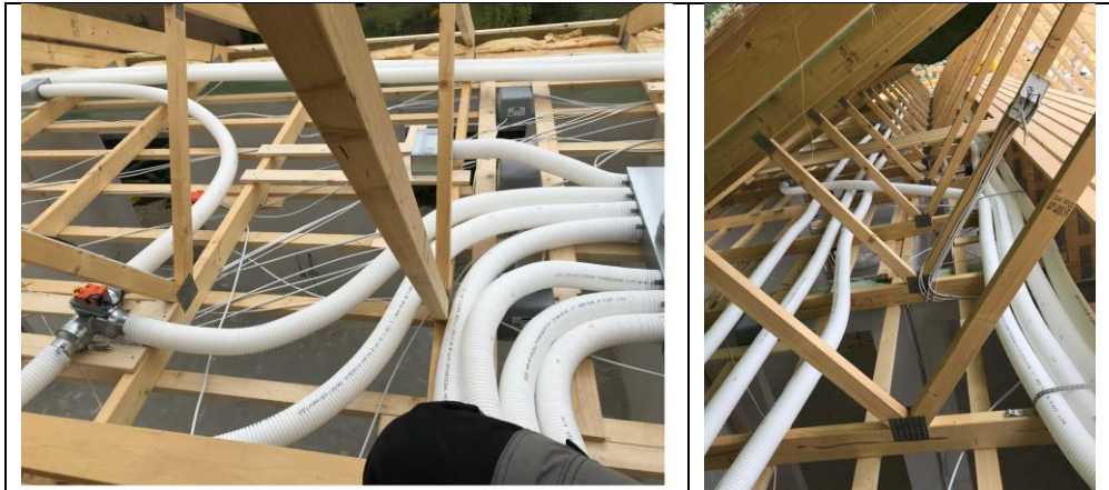
Figur 14. Figuren viser udsnit af slangeføringen fra manifolden.
