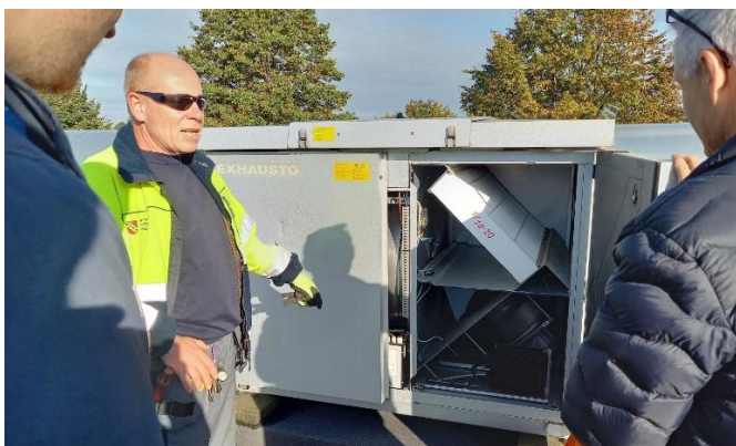
Figur 7: Her frem viser Høje-Taastrup Kommunes ventilations teknik-væsen et tag-placeret ventilationsanlæg under en besigtigelse af skolens ventilationsanlæg
